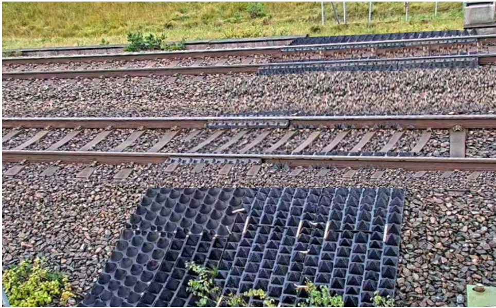
Figur 3.3.10:1. Exempel på pyramidmatta som försvårar för fauna att ta sig in på spåret. Mattorna ska inte som i bilden placeras ovanpå sliprarna. Foto: Mattias Olsson/ EnviroPlanning.
